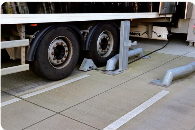
Elektronischer Unterlegkeil, Dokumentation der korrekt genutzten Rampe
