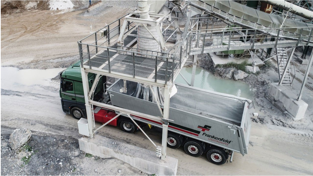
Automatisierte Lieferverfahren: So erfolgt die Verladung der bestellten Güter. Foto: PAARI GmbH
